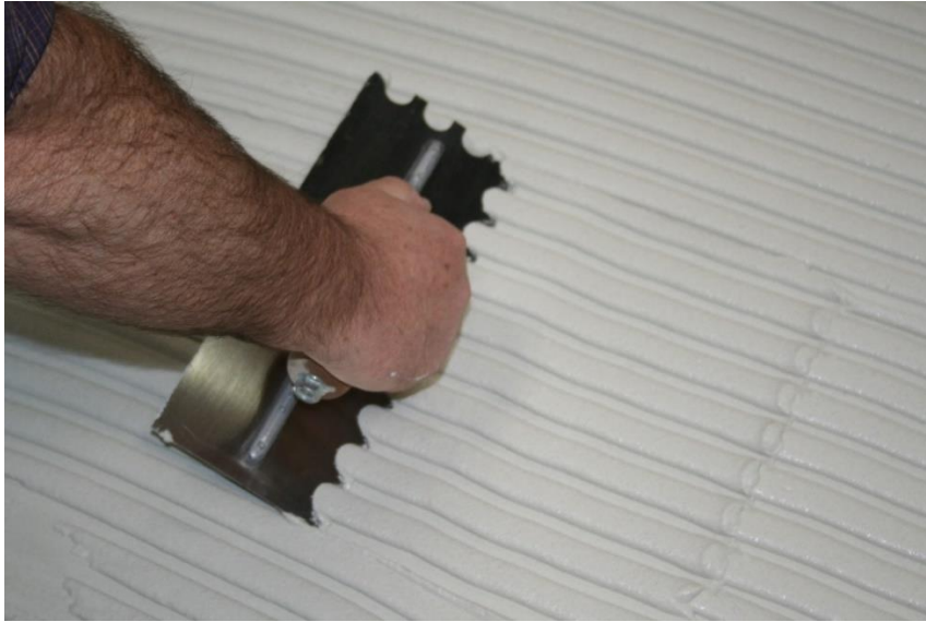
Picture 1.2 - \frac{3}{4} " (18mm) llana dentada con un mortero de capa media usada en baldosas de gran formato. Raye el mortero en una dirección tomando la llana en un ángulo de 45° grados. Note los canales de mortero que quedaron atrás.
